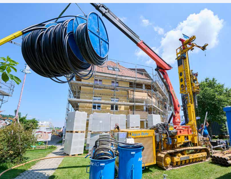
Bohrungen für die Wärmepumpe (Erdsonde) sind im Gange. Diese ersetzt die alte Ölheizung.
