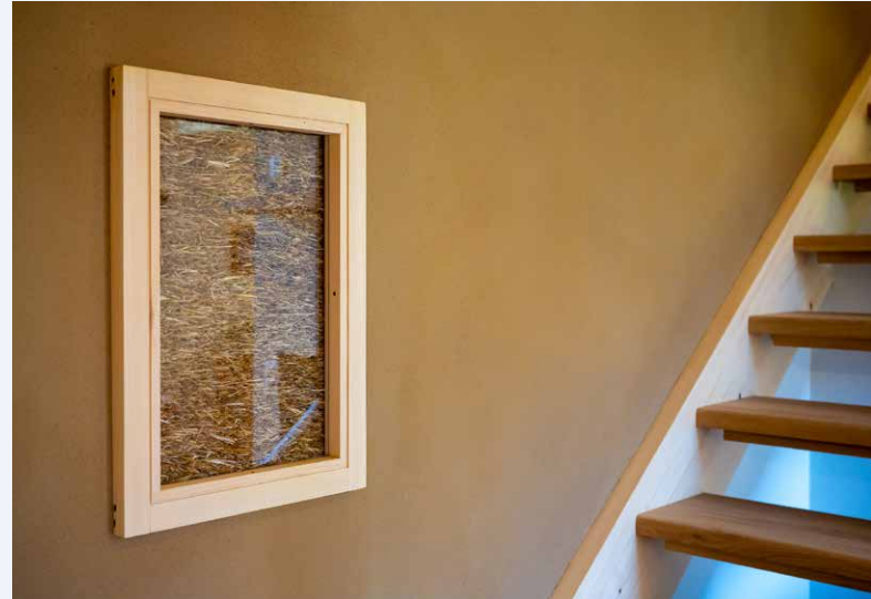
Das Gerüst bildet eine Holzkonstruktion, die mit wärmedämmendem Stroh aufgefüllt und mit Lehm verputzt ist.
