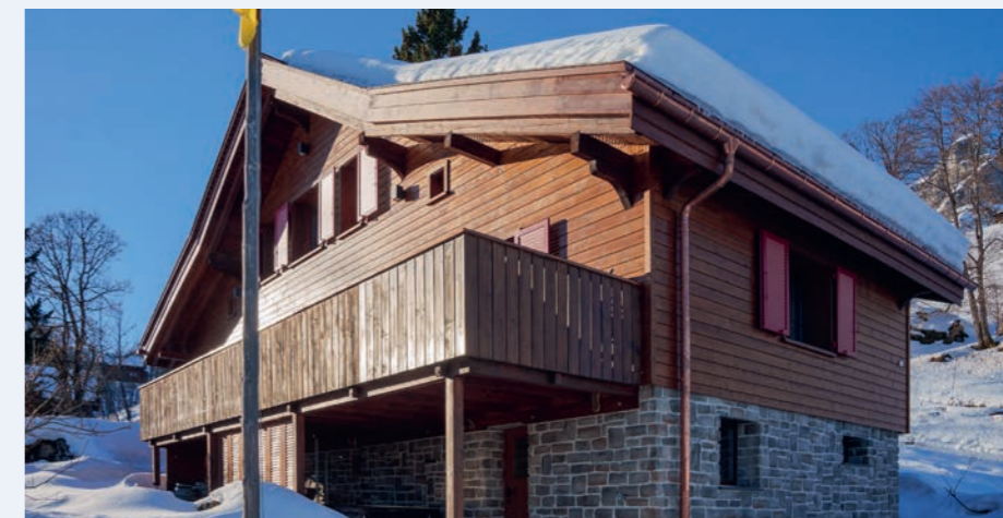
Il nuovo ampliamento ha ripristinato la simmetria dello chalet.
