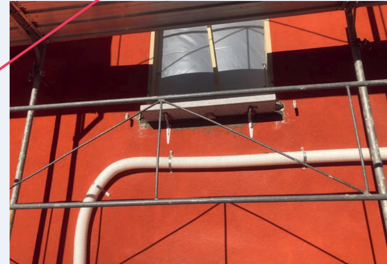
Die Hauswand ist nach der Dämmung rund 20 cm dicker, durch die Dämmschicht verlaufen die neuen Belüftungsrohre.
